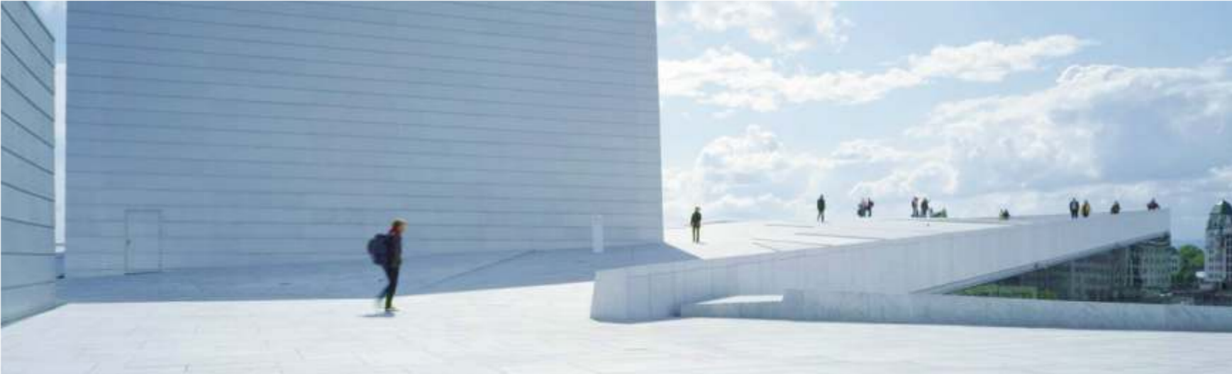
استفاده از سنگ چینی کریستال بوشهمر شده در بنای اپرا - شهراسلو کشور نروژ
